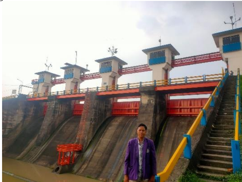
Gambar 01. Pintu Pelimpah Air Bendungan
