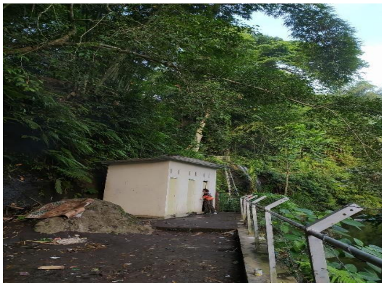
Gambar 6. Fasilitas toilet dan ruang ganti
