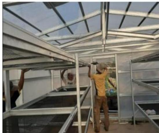
**Gambar 4. Pembangunan *Green House* dengan Turbin Ventilator dan *Air Kiln Dryer* (GH TV AKD)**
