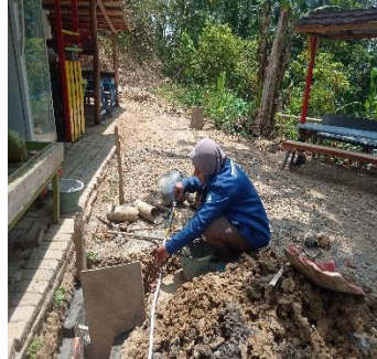
Gambar 6. Pengukuran panjang perbaikan saluran sirkulasi
