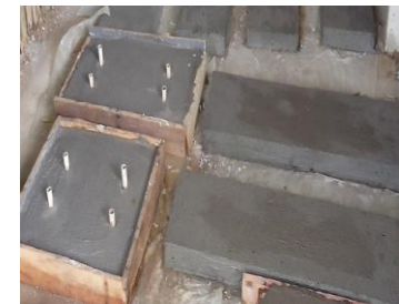
Gambar 10. Pembuatan tutup bak kontrol
