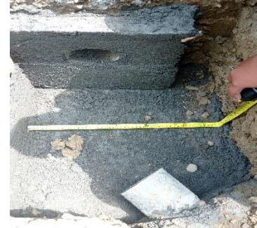
Gambar 7. Perbaikan bak kontrol
