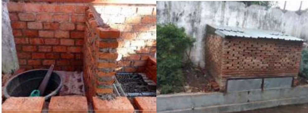
Gambar 1. Pembuatan Bata Terawang
